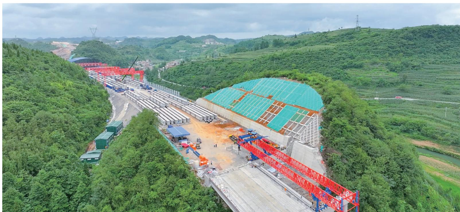
日前,随着最后一长40米、重125吨的预制T梁稳稳坐落在0#台垫石上,标志着沪昆国家高速公路贵阳至安顺段扩容工程项目10标段麦翁河大桥左幅架梁施工顺利完成。
