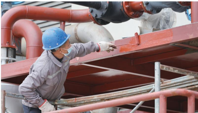
2月22日,在位于安顺经开区的贵州百灵企业集团制药股份有限公司,贵州百灵扩能技改项目施工现场繁忙有序,该项目自大年初四复工建设以来,每天有近80人在现场作业,铆足干劲,奋力冲刺一季度“开门红”。据悉,该项目总投资达59793.5万元,主要包括建设甲类提取车间、丙类提取车间、前处理车间、中药材仓库、危险品库、罐区等区域。图为工人正在为建设中的丙类车间设备平台焊接处刷漆。 早报记者 唐琪 摄
