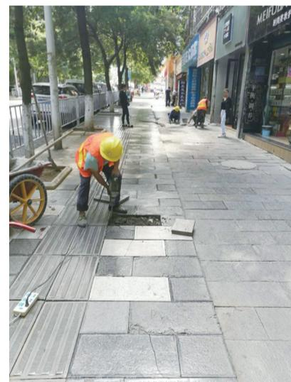
为给市民出行提供舒适的出行环境,安顺市西秀区城管局市政管理处近日正在对城区破损人行道进行巡查和维修,前期已对九小附近,凤缘路,龙泉路,塔东路等路段的破损人行道板进行维修,现正在对体育路进行维修。下一步将继续对城区破损人行道进行巡查统计和维修。
