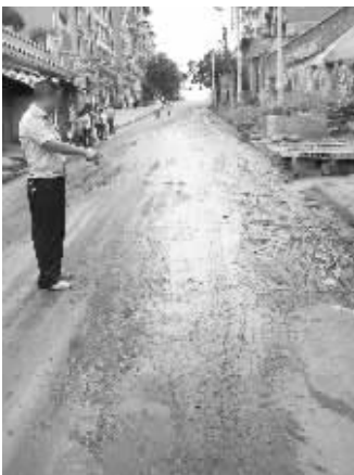
被化粪池淤物污染的街面
