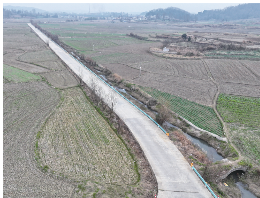
詹屯村临水沟路段安装防护栏
