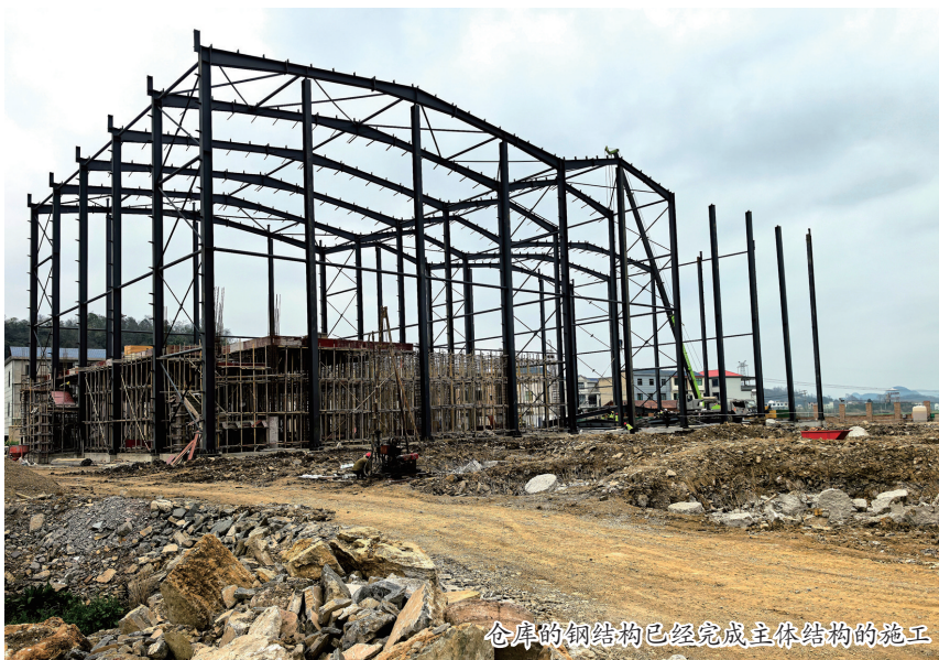
仓库的钢结构已经完成主体结构的施工
