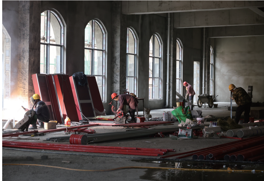
工人正在楼内施工
