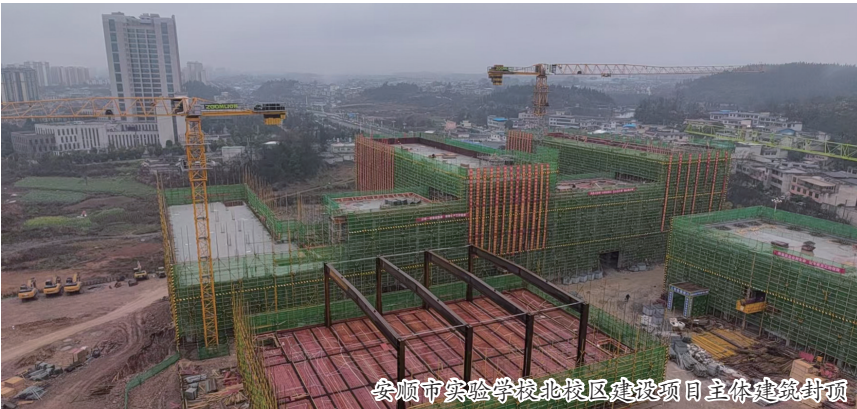
安顺市实验学校北校区建设项目主体建筑封顶
