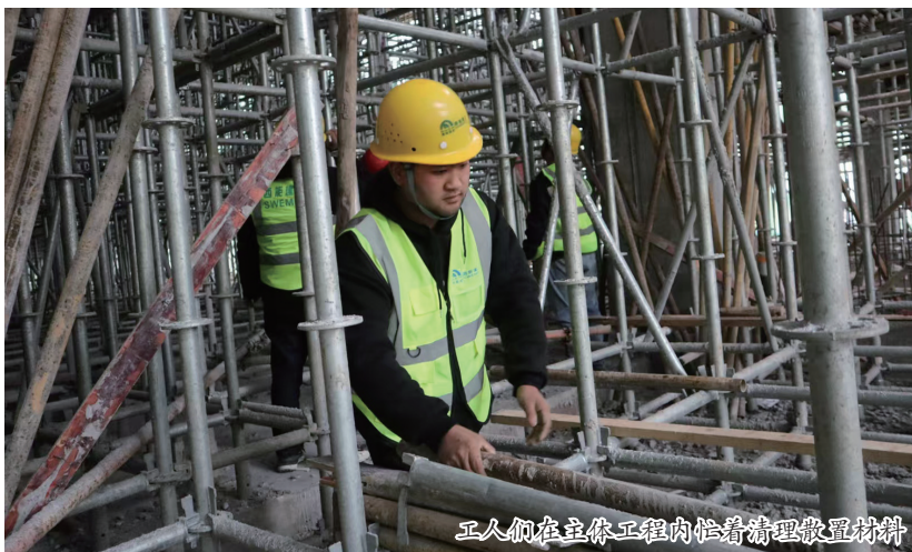
工人们在施工现场内进行清理散置材料
