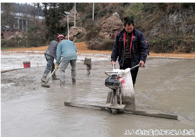
工人进行篮球场混凝土浇筑
