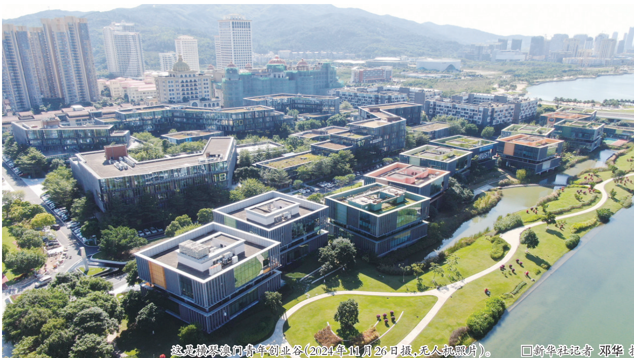
这是博鳌亚洲论坛永久会址(2024年11月26日摄,无人机拍摄)。 □新华社记者 邓华 摄
