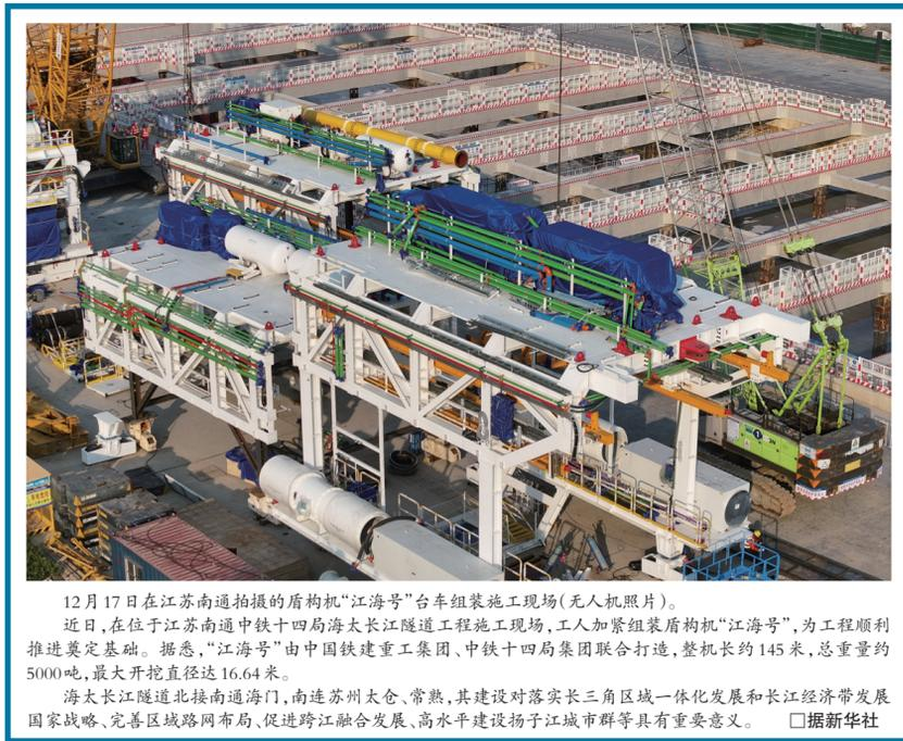
12月17日在江苏南通拍摄的盾构机“江海号”台车组施工现场(无人机照片)。近日,在位于江苏南通中铁十四局海太长江隧道工程施工现场,工人加紧组装盾构机“江海号”,为工程顺利推进奠定基础。据悉,“江海号”由中国铁建重工集团、中铁十四局集团联合打造,整机长约145米,总重量约5000吨,最大开挖直径达16.64米。
