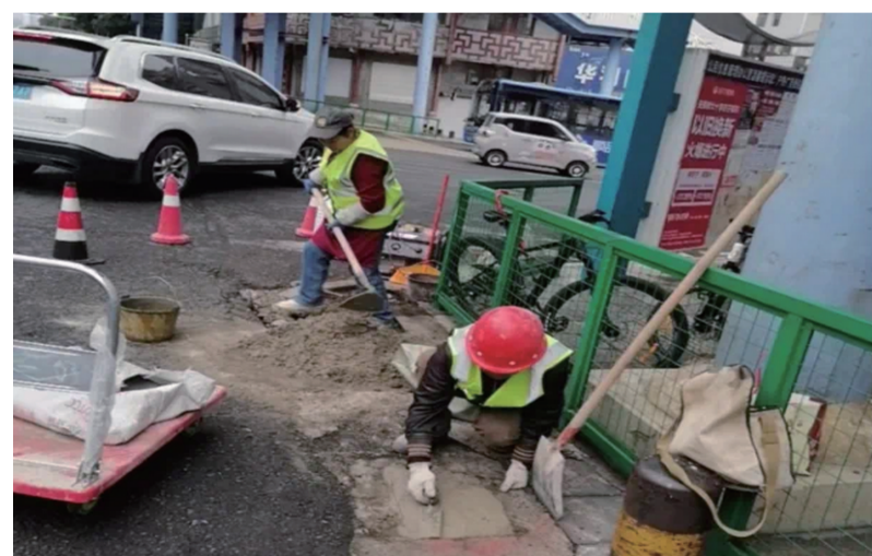
近日,西秀区市政管理处对城区中华北路、中华南路等路段的破损路面进行修缮,确保群众方便、安全出行。
