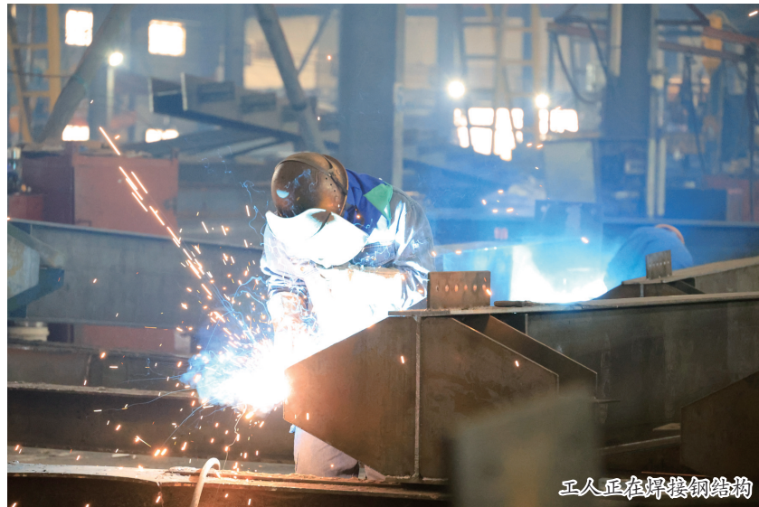
工人正在焊接钢结构
