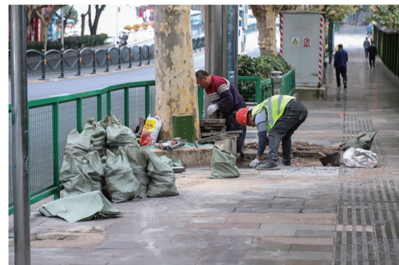
11月18日,记者在塔山东路看到,工人对破损的路面进行修复。近期,市政工程养护中心对城区内松动、破损的人行道地砖开展全面维修,确保市民出行顺畅安全。 □记者 卢维 摄
