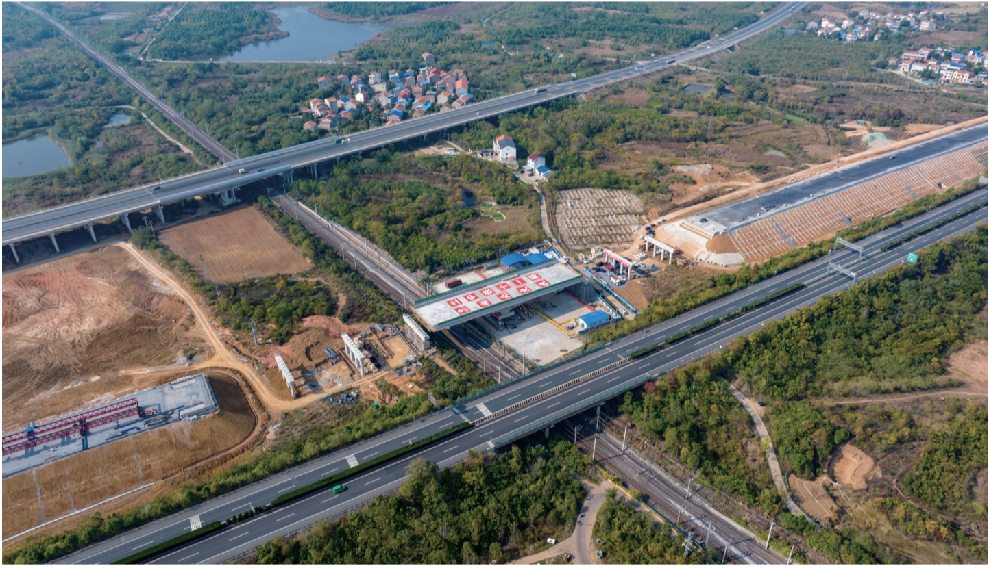
11月12日,新建京港澳高速改扩建工程湖北北段上跨京广铁路立交桥转体完成(无人机照片)。当日,由中铁十一局承建的新建京港澳高速改扩建工程湖北北段上跨京广铁路立交桥,经过60分钟逆时针旋转84度后,跨越京广铁路,实现成功转体。该桥位于湖北省孝感市孝南区,转体桥采用全架现浇转体施工,长90米,宽25.51米,转体重量达11000吨。□据新华社
