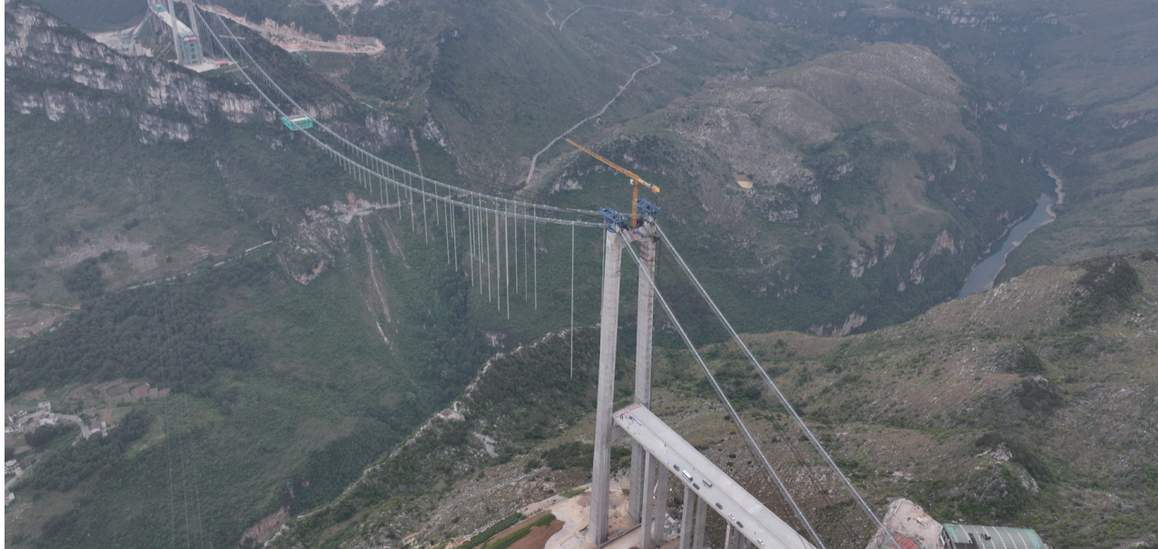
建设中的花江峡谷大桥航拍图 □记者 陈婷 摄
