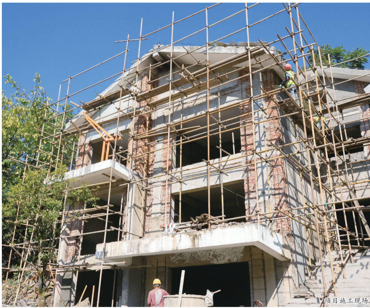
项目施工现场
