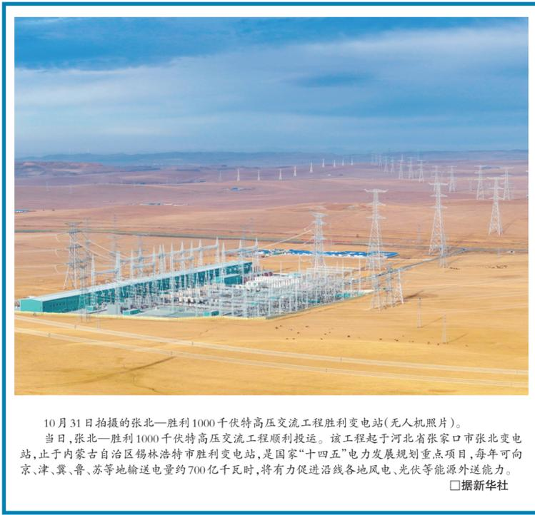
10月31日拍摄的张北—胜利1000千伏特高压交流工程胜利变电站(无人机照片)。当日,张北—胜利1000千伏特高压交流工程顺利投运。该工程起于河北省张家口市张北变电站,止于内蒙古自治区锡林浩特市胜利变电站,是国家“十四五”电力发展规划重点项目,每年可向京、津、冀、鲁、苏等地输送电量约700亿千瓦时,将有力促进沿线各地风电、光伏等能源外送能力。 □据新华社
