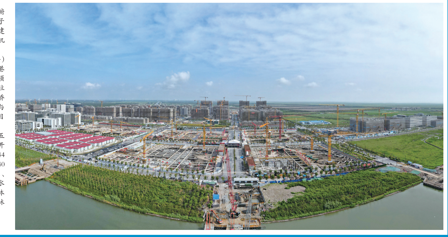
8月20日，空中俯瞰金桥临港汽车电子融合与应用研创园建设项目现场(无人机照片)。
