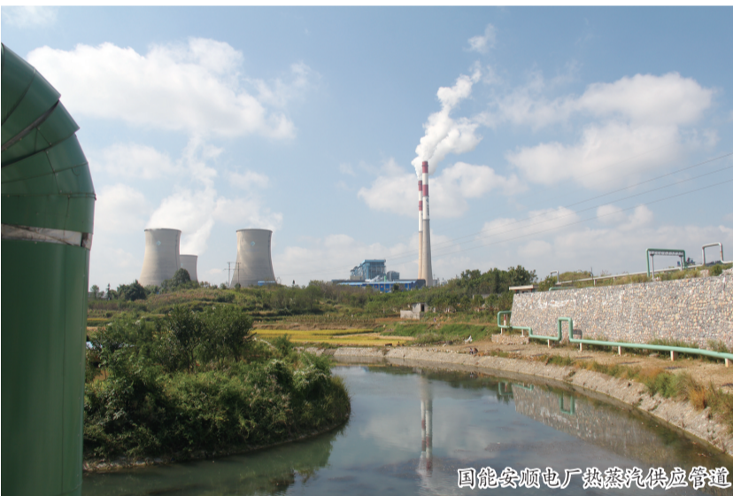
国能安顺电厂热蒸汽供应管道
