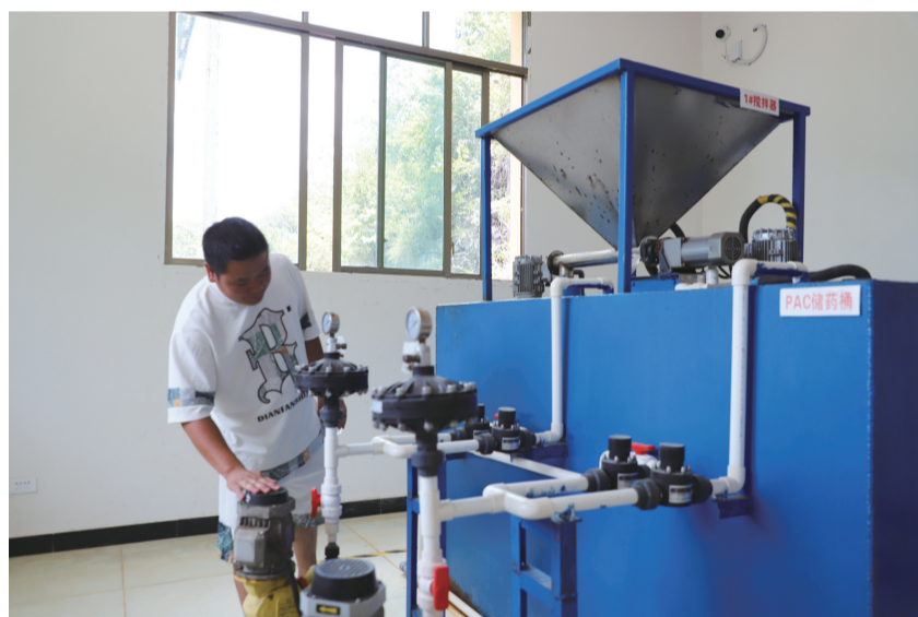
化处水厂工作人员检查供水设备
