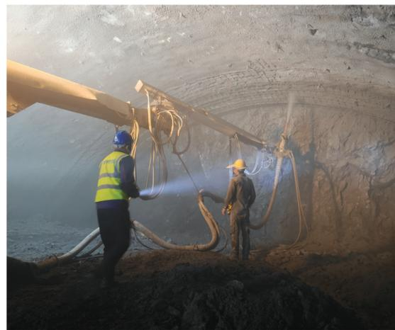
7月28日,由中铁七局承建的安盘高速APTJ-2标青岗林隧道进口成功完成瓦斯段掘进施工。青岗林隧道作为安盘高速全线重点难点工程,进口端左线有415米、右线400米为含煤地层,属高瓦斯工区,且在龙潭组煤系地层内,该区域共穿越6道煤层,具有瓦斯突出、采空区塌陷、老窑突水等高风险。为此,该工程项目部制定专项施工方案,严格按照“管超前、严注浆、短开挖、强支护、早封闭、勤量测”方针,经过37个日夜的努力,顺利穿越煤层。
