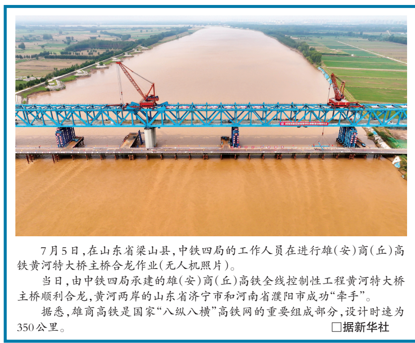
7月5日,在山东省梁山县,中铁四局的工作人员在进行雄(安)商(丘)高铁黄河特大桥主桥合龙作业(无人机照片)。当日,由中铁四局承建的雄(安)商(丘)高铁全线控制性工程黄河特大桥主桥顺利合龙,黄河两岸的山东省济宁市和河南省濮阳市成功“牵手”。据悉,雄商高铁是国家“八纵八横”高铁网的重要组成部分,设计时速为350公里。□据新华社
