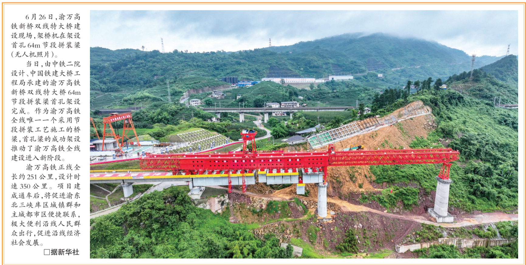
6月26日,渝万高铁新桥双线特大桥梁建设现场,架桥机在架设首孔64m节段拼装梁(无人机照片)。
