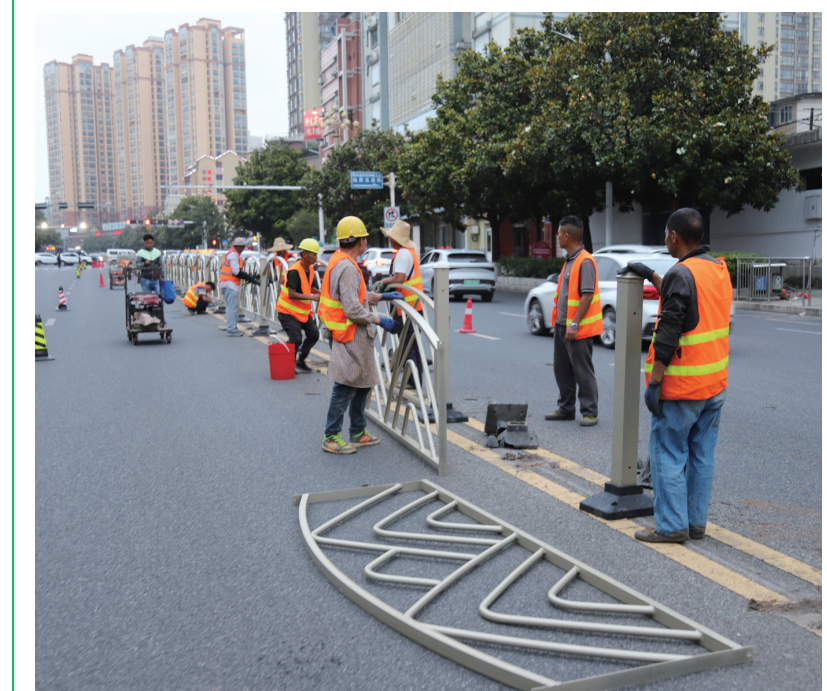
6月18日,安顺经开区更换交通护栏15公里,因为西航路多名工人正在进行安装。
