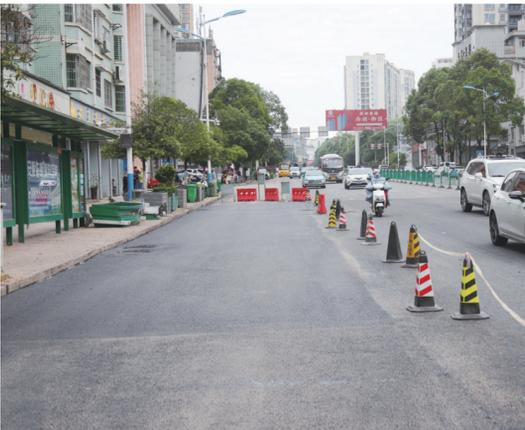
6月12日,记者在安顺经开区北航路排水防涝管网提质改造项目施工现场看到,该项目即将完工,工人们在做最后的设施恢复施工。据介绍,此次安顺经开区排水防涝管网提质改造项目总投资14502.2万元,共计将改造排水防涝管网20233.5米,计划分批对北航路、玉龙北路、南马大道等区域进行管网改造,旨在解决城市水质问题以及内涝现象,确保城区防洪通道畅通,提升城市功能品质。
