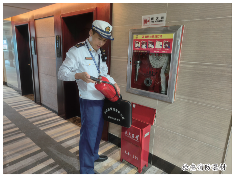
检查消防器材
