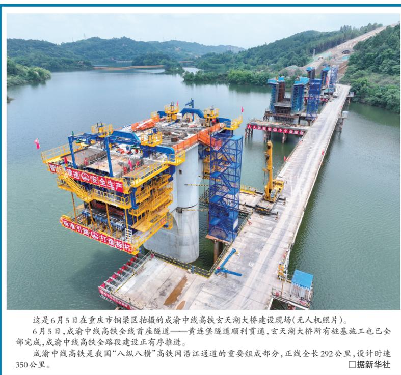
这是6月5日在重庆市铜梁区拍摄的成渝中线高铁玄天湖大桥建设现场(无人照照片)。6月5日,成渝中线高铁全线首座隧道——黄连堡隧道顺利贯通,玄天湖大桥所有桩基施工也已全部完成,成渝中线高铁全线建设正有序推进。成渝中线高铁是我国“八纵八横”高铁网沿江通道的重要组成部分,正线全长292公里,设计时速350公里。 □据新华社
