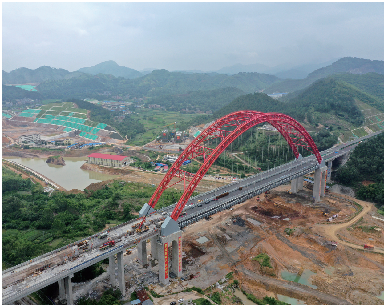
6月2日，在广西灵山县境内的南湛高速公路旧州特大桥引桥上，中铁二十五局工人在施工中（无人机照片）。
