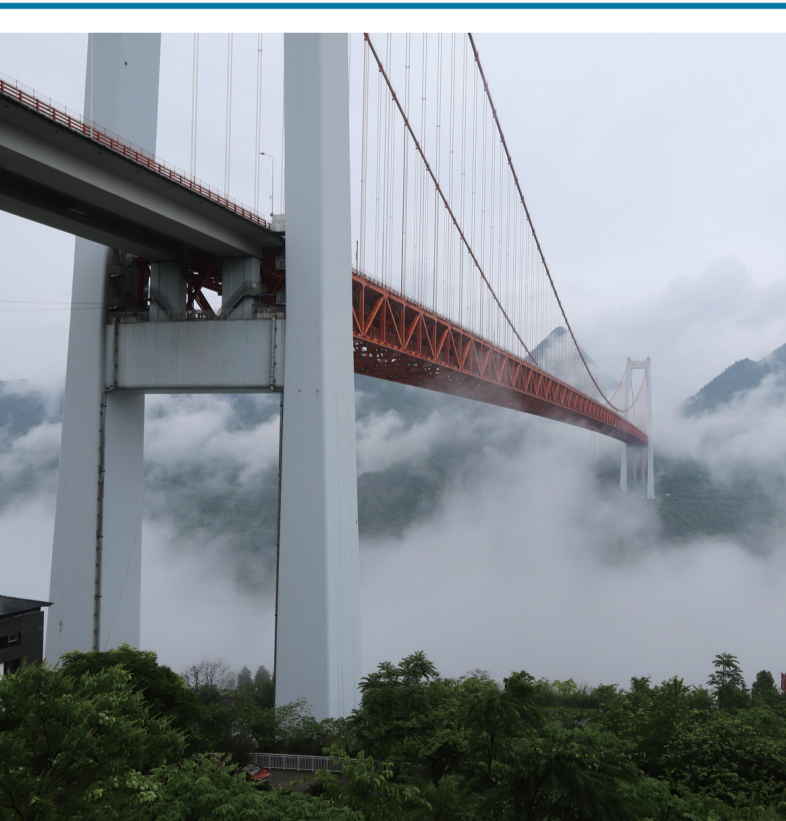
5月28日,一场小雨过后,坝陵河大桥云雾缭绕,美若仙境。
