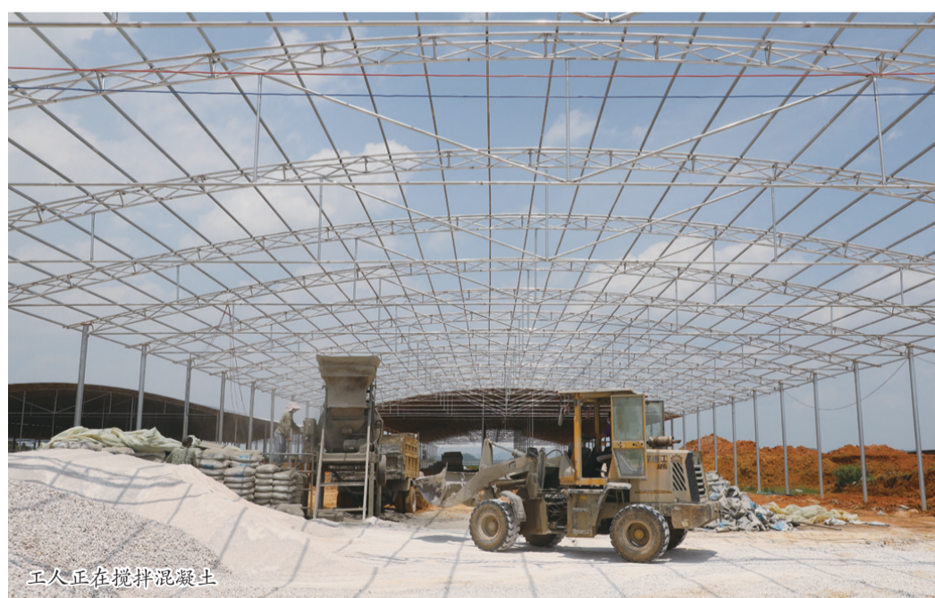
工人正在搅拌混凝土
