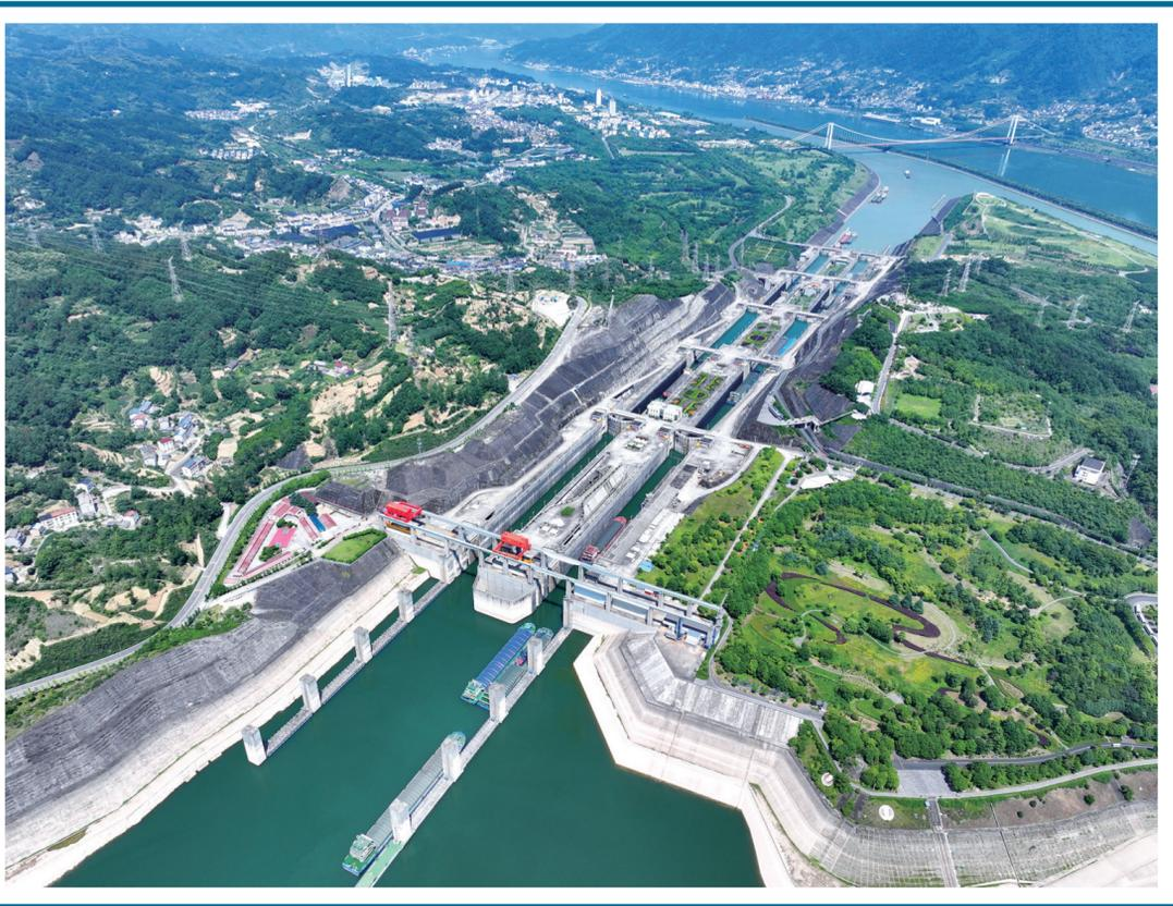
5月23日,在湖北省宜昌市,船舶有序通过三峡双线五级船闸(无人机组照片)。截至5月21日,三峡枢纽货运量达20.81亿吨。三峡工程的建设和蓄水,改善了长江中上游航运条件,三峡船闸和三峡升船机联合运行,形成了“大船爬楼梯、小船坐电梯”的通航格局。□据新华社
