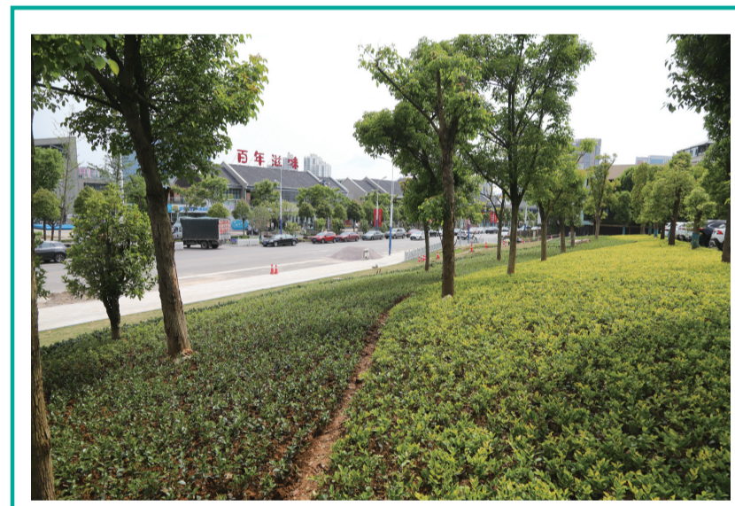
5月14日,记者在虹山湖公园海绵城市改造项目实施现场看到,改造工程基本完工。据悉,该工程主要是改造绿化带中的场地,改迁原有绿化植被,开挖出植草沟及雨水花园,并埋设雨水花园下的透水盲管,从而实现雨水的自然积存、自然渗透、自然净化和可持续水循环。 □记者 卢维 摄
