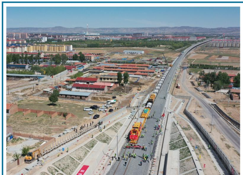
5月15日，工人和铺轨机在现场作业(无人机照片)。当日，在内蒙古乌兰察布市丰镇县集宁至大同至太原高速铁路建设现场，铺轨机在自动铺设枕轨，工人在岗位上有序忙碌，标志着集宁至太原高速铁路全线开始铺轨。集宁至太原高速铁路是我国“八纵八横”高速铁路网呼南通道的重要组成部分，预计2024年底具备通车条件。 □据新华社
