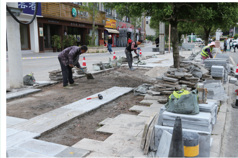
5月6日,记者在武当路看到,工人对该路段破损的人行道进行修复,重新铺上地砖,让群众安全方便出行。
