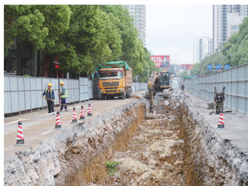
为保障市民出行安全,给市民营造良好的居住环境,进一步提升城市整体形象,安顺经开区对北航路碧水园段进行排水防涝管网提质改造。图为4月25日,安顺经开区北航路碧水园段施工现场。
