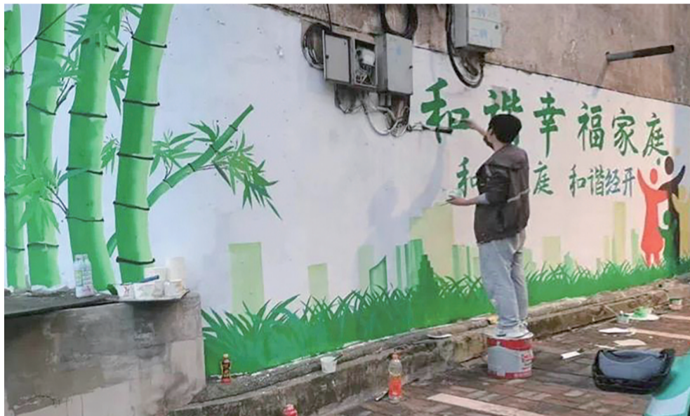
工作人员对小巷部分墙体进行美化
