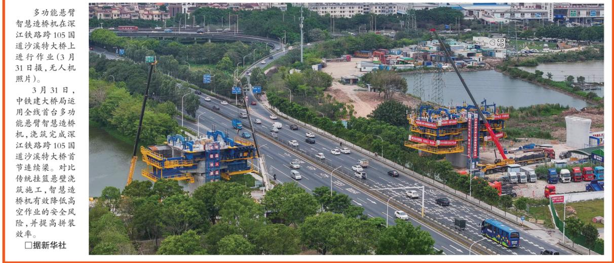
多功能悬臂智慧造桥机在深江铁路跨105国道沙漠特大桥上进行作业(3月31日摄,无人机照片)。
