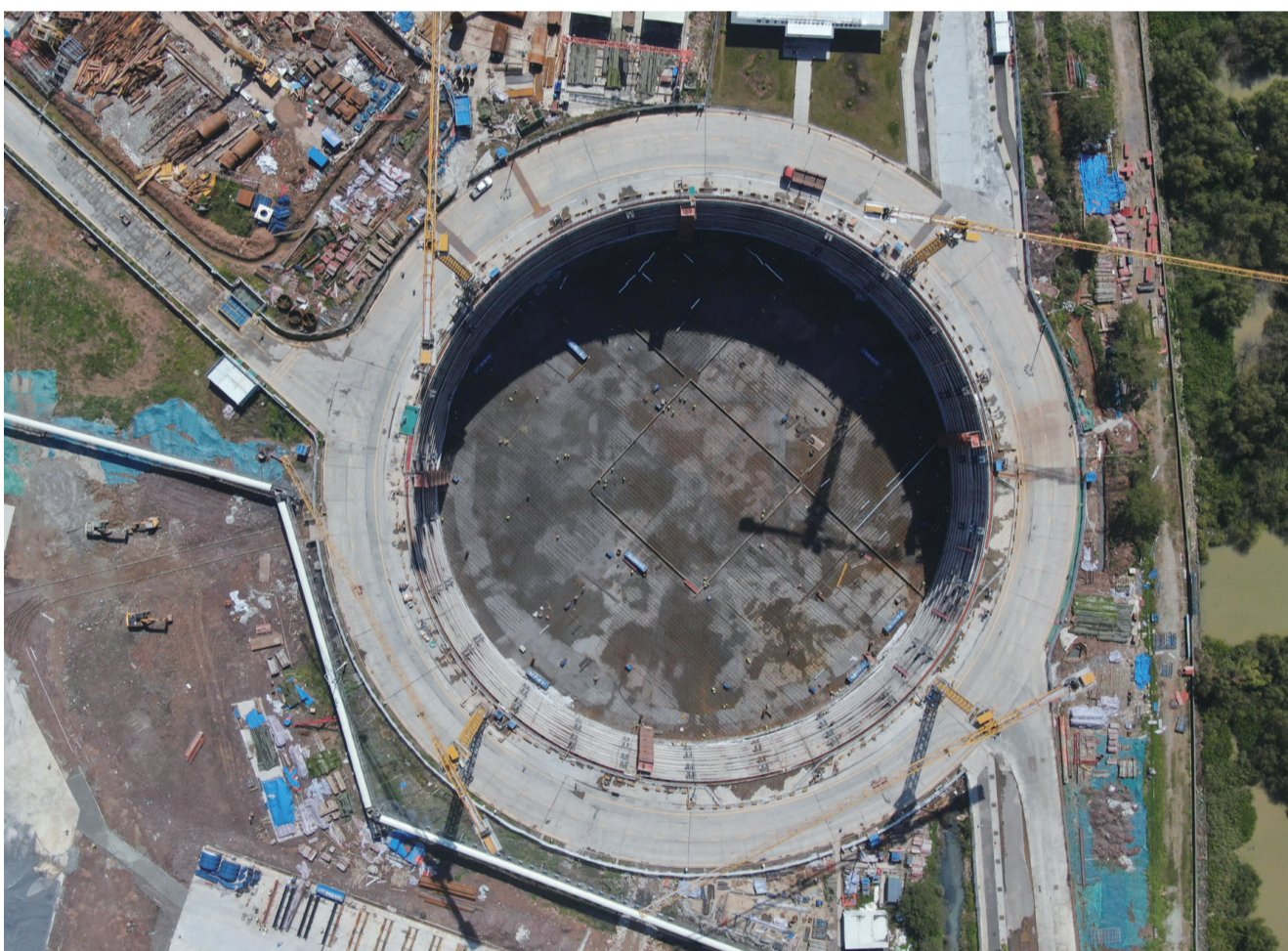
这是中交第二公路工程有限公司承建的狮子洋大桥西锚碇施工现场(3月12日摄,无人机照片)。
