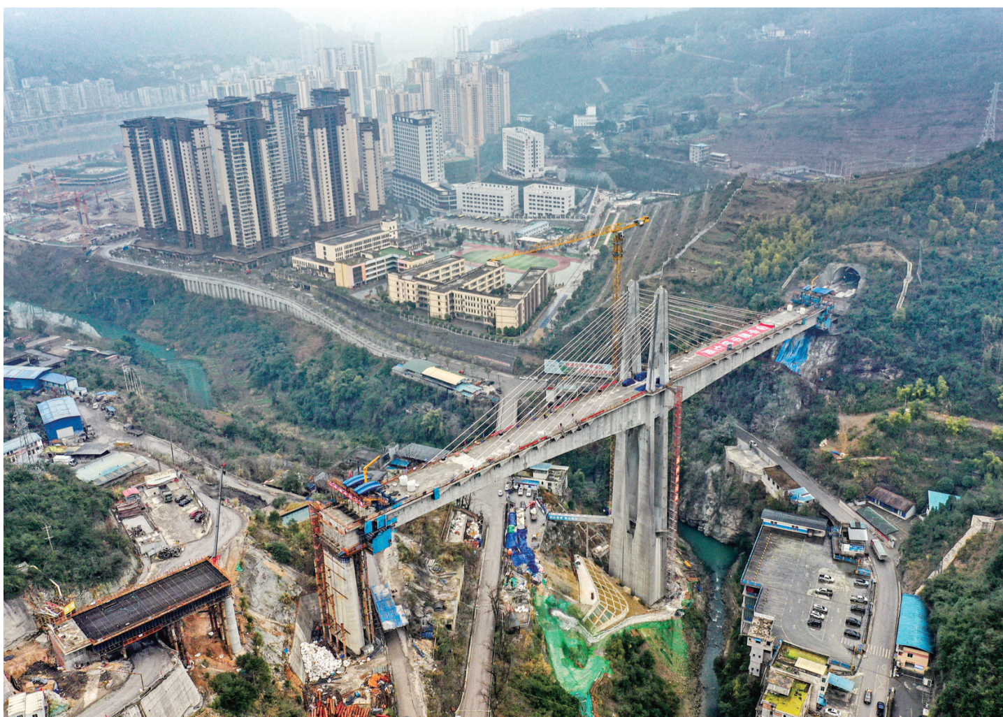
这是1月31日拍摄的渝湘高铁长途河双线大桥施工现场(无人机照片)。
