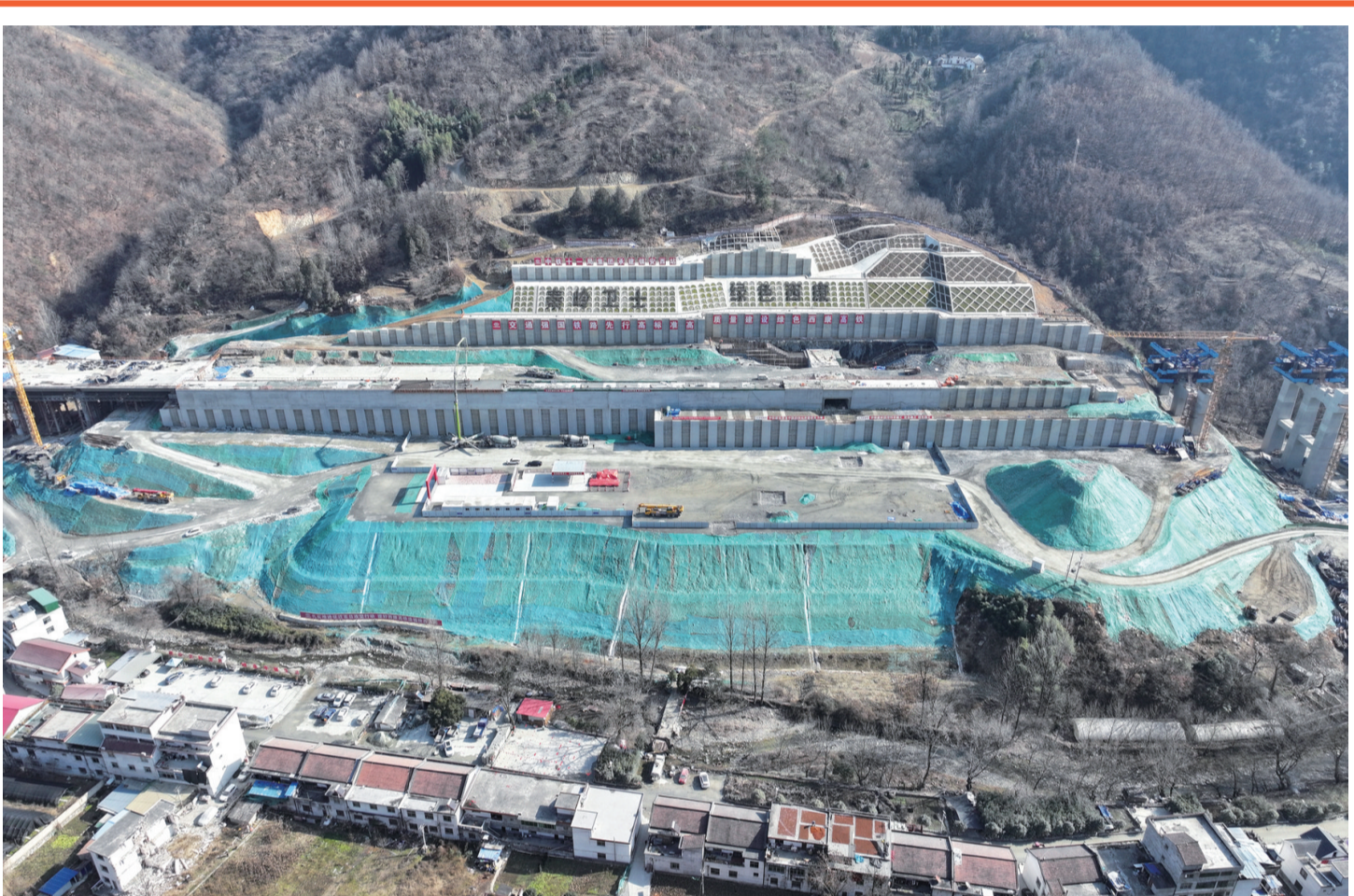
1月26日拍摄的建设中的西康高铁安西站(无人机照片)。
