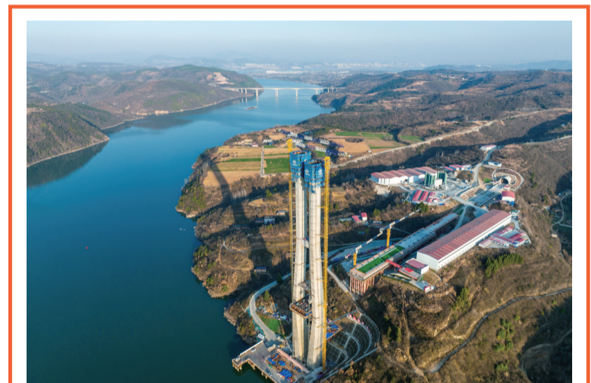
12月24日拍摄的汉江特大桥P4主塔施工现场(无人机照片)。当日,由中铁十一局承建的西(安)十(堰)高铁汉江特大桥P4主塔顺利封顶。汉江特大桥位于湖北省十堰市,是一座梁桁组合结构斜拉桥,全长917.45米,P3、P4两座主塔高度均为186.5米,共设置80对斜拉索,主跨420米。
