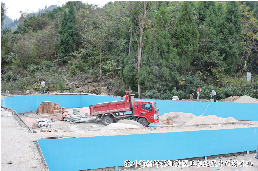
落叶新村坪寨河景区正在建设中的游泳池
