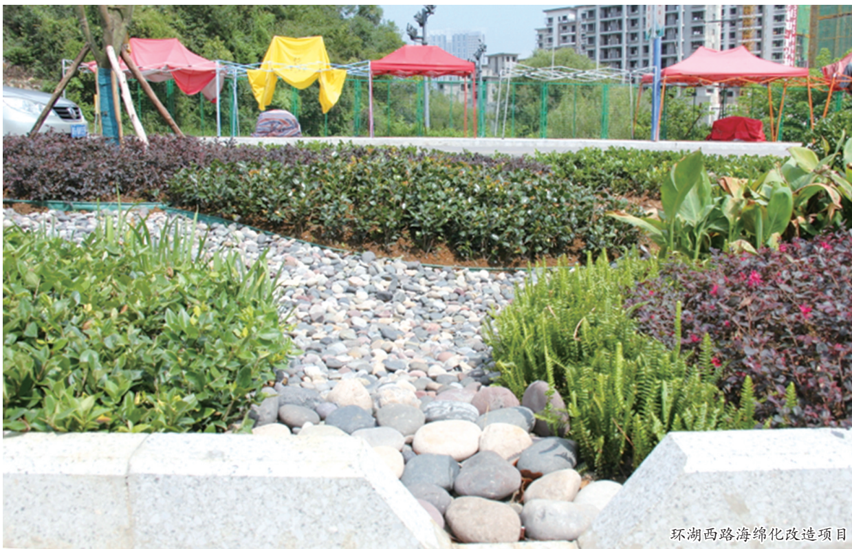
环湖西路海绵化改造项目
