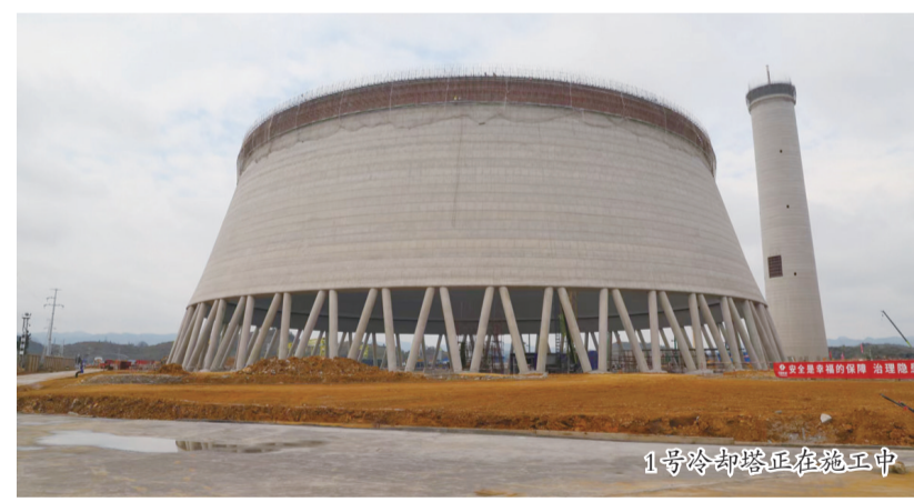
1号冷却塔正在施工中
