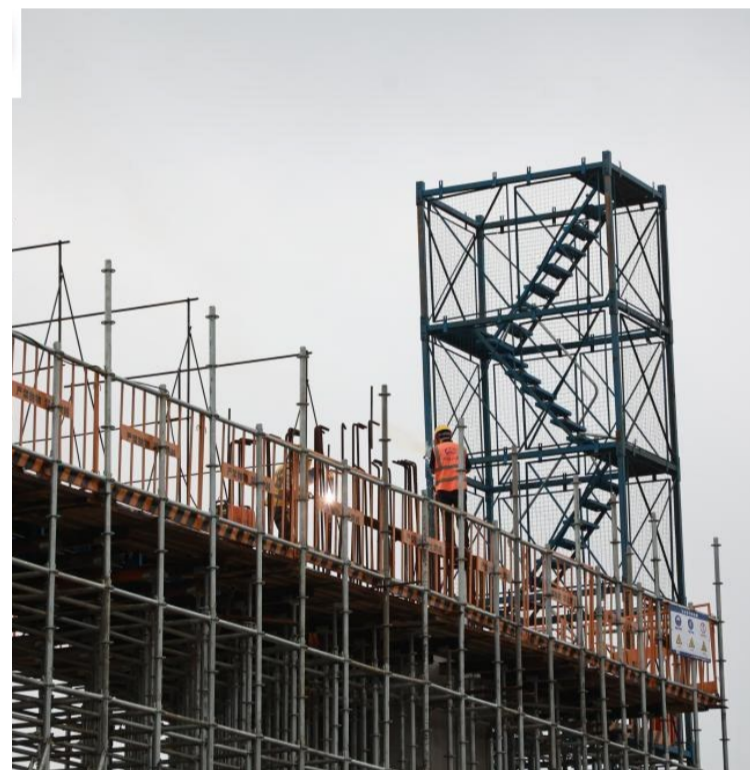
12月16日,工作人员正在木寨多线大桥上施工。近日,由中铁八局承建的贵南高铁西联线木寨多线大桥正在进行紧张的桩基施工,目前完成量已超过80%。据了解,贵南高铁是我国“八纵八横”高速铁路主通道包头至海口通道的重要组成部分,设计时速350公里。
