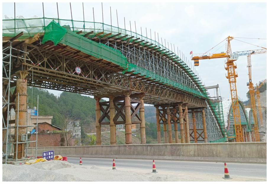
12月8日,记者在紫云自治县板当镇同合村看到,黄家湾水利枢纽工程长距离输水工程1号波槽建设正在有序进行。据了解,同合桥波槽是黄家湾水利枢纽工程长距离输水工程的输水总渠波槽,该波槽长150多米,最高桥墩50米。
