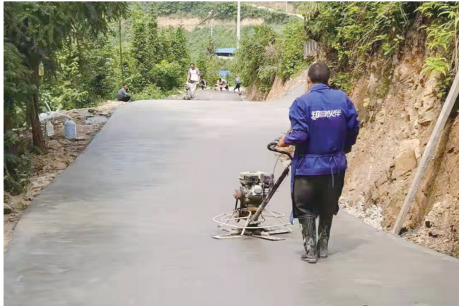
建设中的团坡村机耕道
