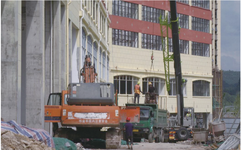
7月14日,记者从安顺市实验学校经开区分校建设项目处获悉,该校建设有序推进,目前主体结构建设已经全部完成,项目进入收尾阶段,预计7月底完成竣工验收,计划于9月投入使用。
