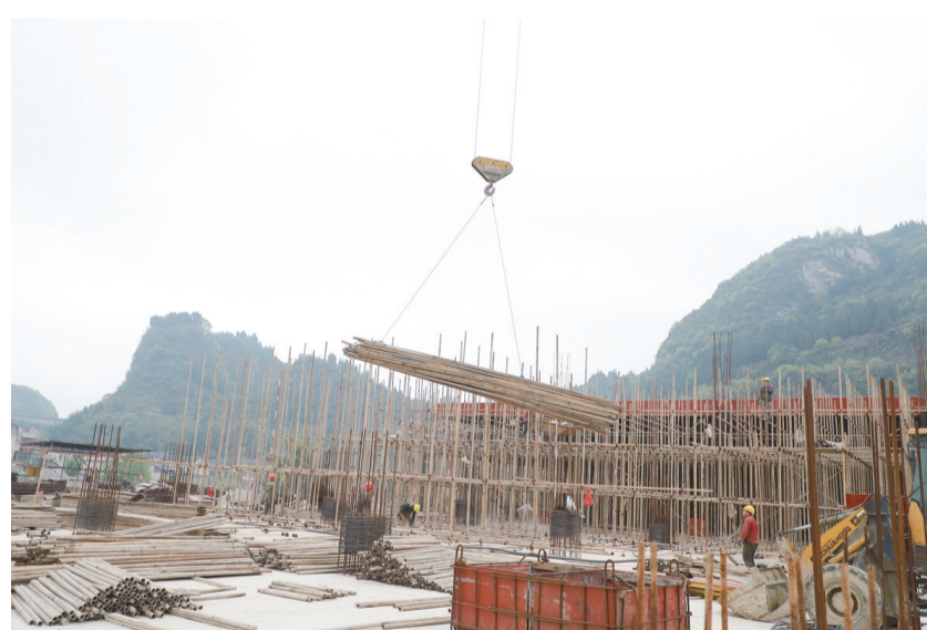
日前,记者来到位于关岭自治县顶云街道八角岩食药园内的易地扶贫搬迁安置点返乡创业园项目建设现场,只见工人们正在进行主体施工,项目建设有序推进。据悉,该项目总占地面积约101亩,建设标准厂房100000平方米。项目分两期实施,一期工程已完成50000平方米标准化厂房建设,共12栋;二期建设5栋标准化厂房,共建设50039平方米,预计今年年底完工。
