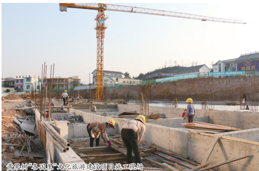
黄果树“各国里”文化旅游建设项目施工现场
